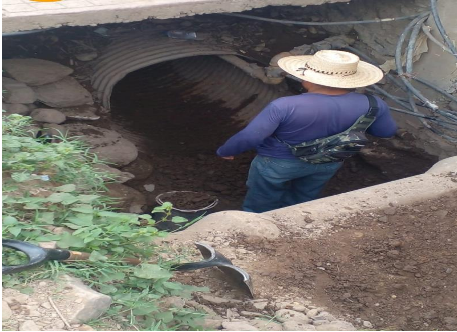
Desazolve y limpieza de barrancas
